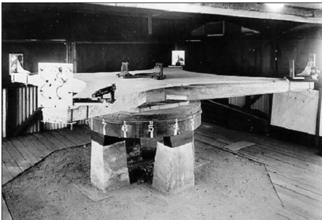
Рис. 13. Интерферометр с базой из бетона, 1921 г.
